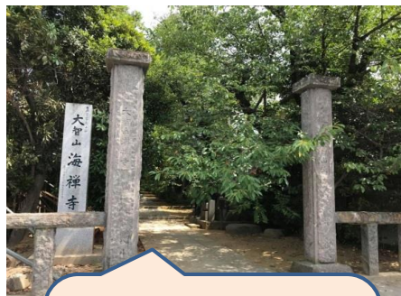
左右に渡してあった石を外し、左右の石柱を短くしました。また敷石は既存の石を一度全て剥がして、敷き直しました。
