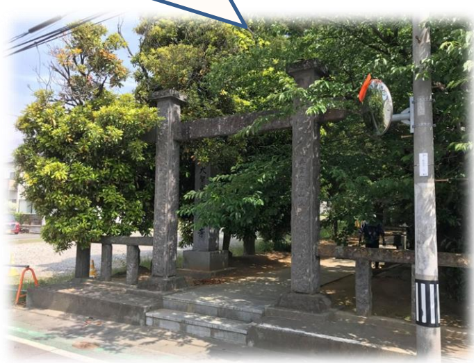
着工前の参道石門周辺の様子
